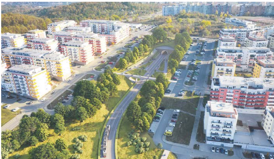
Tramvaj na Kamechy, portál tunelu
